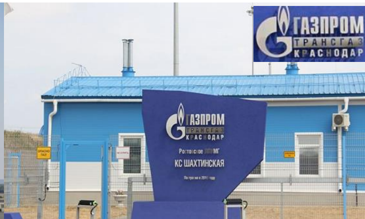
Компрессорная станция «Шахтинская»
